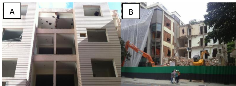
Figura 4 – Demolição Seletiva (A) e Demolição Destrutiva (B)
